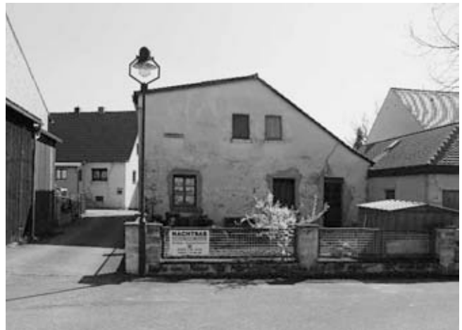
Das ehemalige jüdische Schulgebäude, 2007. Foto: Angela Hager
