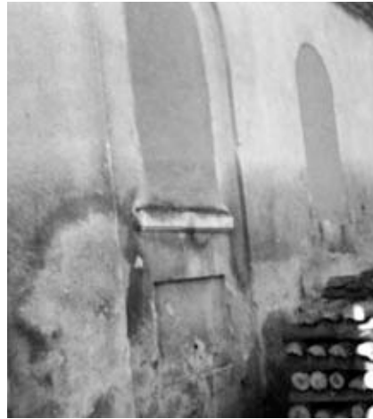
Blick auf die vermauerten Fenster der Synagoge. Quelle: Wilfried Jung
